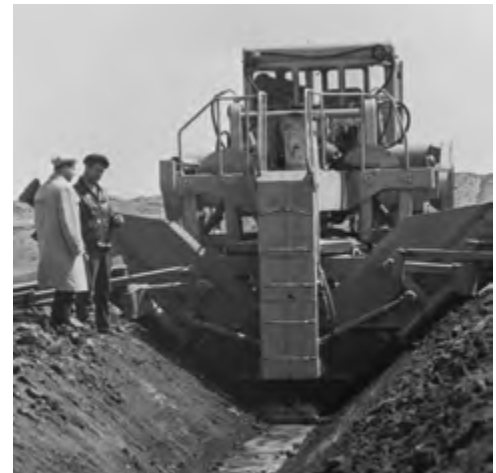
Экскаватор ЭТР-122, созданный на базе Т-180Г, прокладывает канал в совхозе «Заря коммунизма». Украина. 1967 г.
