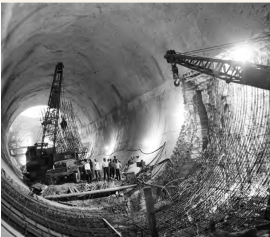
Монтаж металлоконструкций в одном из тоннелей Асуанского гидроузла. 1964 г.
