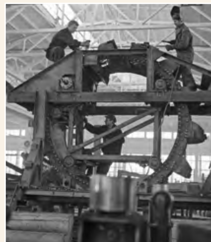
На сборке ротора траншейного экскаватора ЭР-7А. 1969 г.
