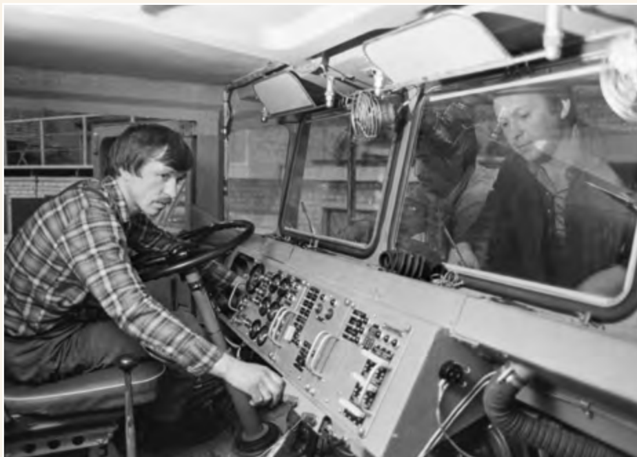
Монтажа электрооборудования в кабине нового вездехода брянских автомобилестроителей. 1988 г.
