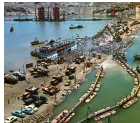
Строительство первой очереди Асуанской плотины. Торжественная церемония перекрытия Нила. 1964 г.
